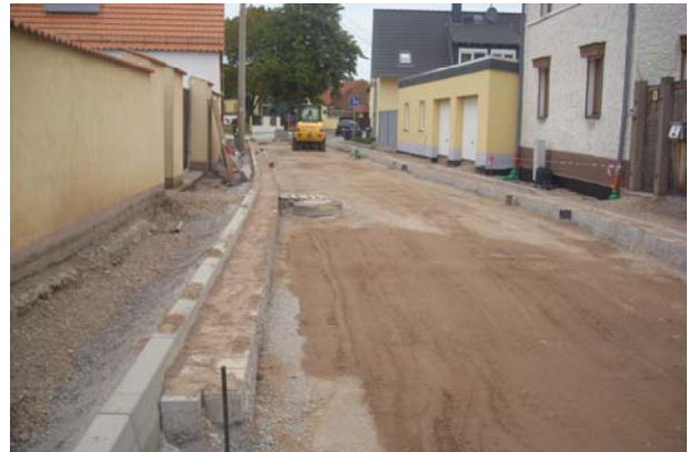
Einbau Bordanlage mit Betonrinne und Frostschutzeinbau
