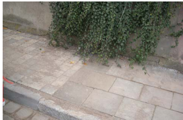
Bauende des Gehweges mit Anpassung zum nächsten Bauabschnitt
